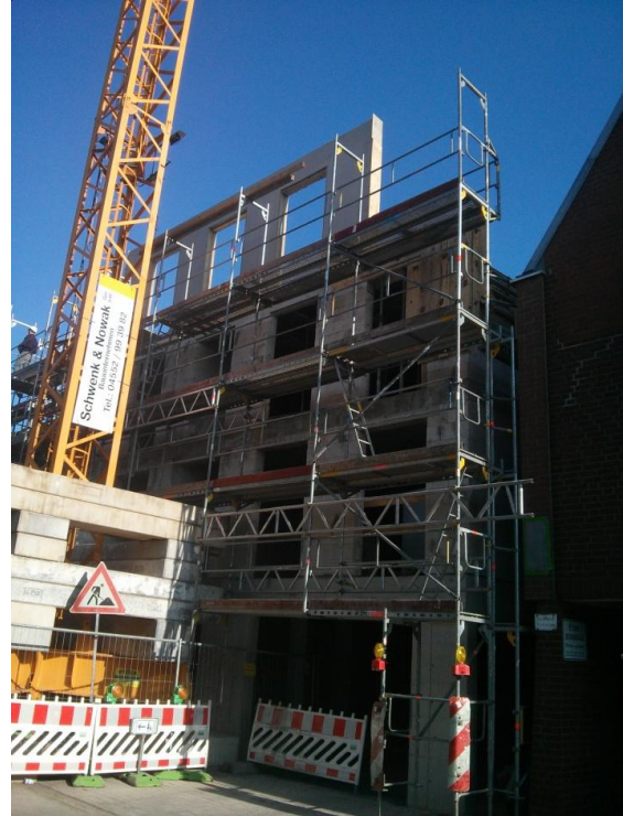
Rohbaufertigstellung „KUR-120“, Travemünde
